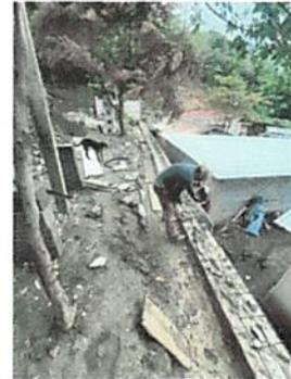
Foto 2: MURO DE CONTENCIÓN
